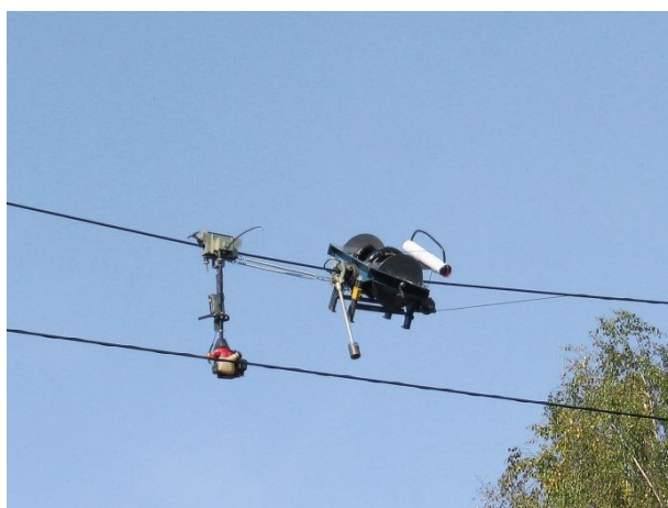
Рисунок 7.4.3 Навивная машинка рамного типа
