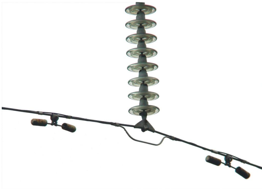
Рисунок 4.16.6 Обвод ОКНН поддерживающего изолятора ВЛ 110 кВ
