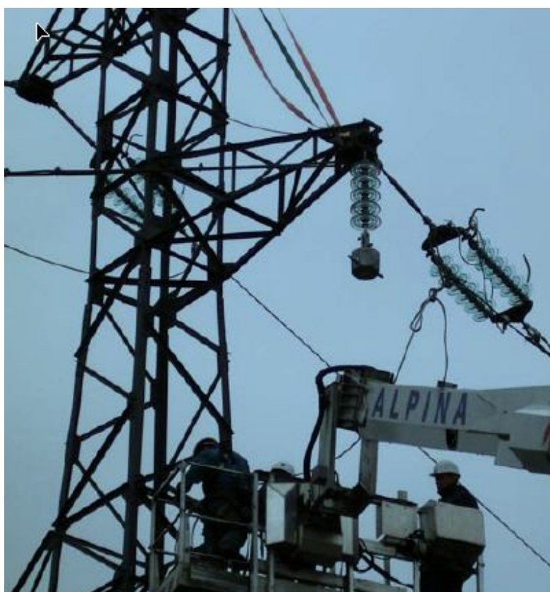
Рисунок 4.14.3 Соединительная муфта [25], готовая для монтажа ОКФП на анкерной опоре
