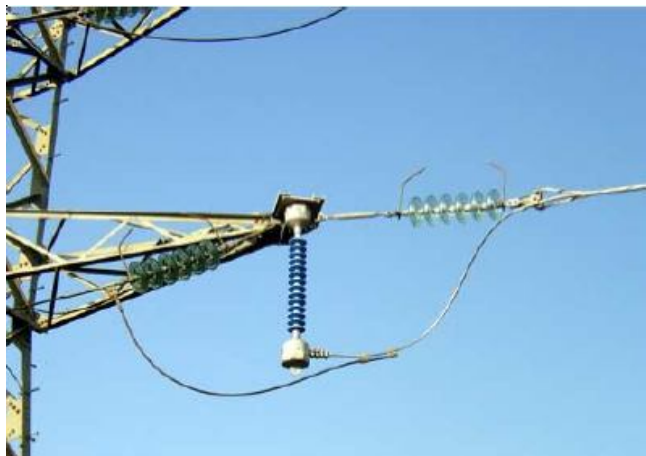
Рисунок 4.14.5 Установка подвесной концевой муфты ОКФП [25]
